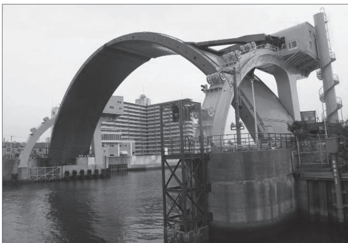
図－1 尻無川水門（高潮対策として整備した3大水門の一つであるが、現在は津波警報が発表された場合に閉鎖する運用としている）
