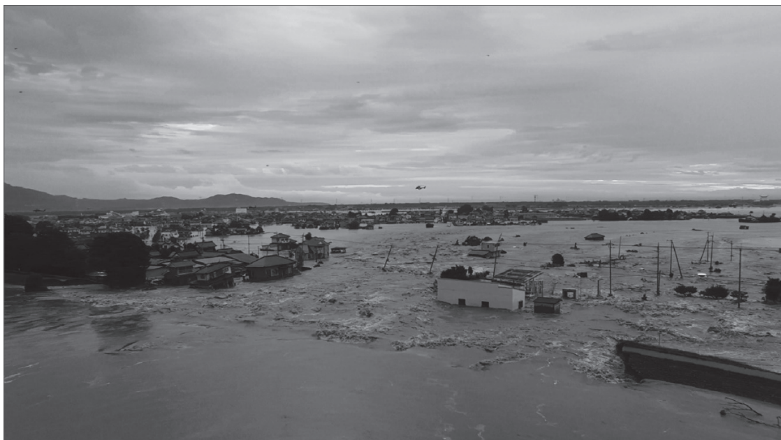
UAV により関東・東北豪雨による鬼怒川破堤箇所の動画を撮影 撮影日時：平成 27 年 9 月 10 日 撮影高度：10m
